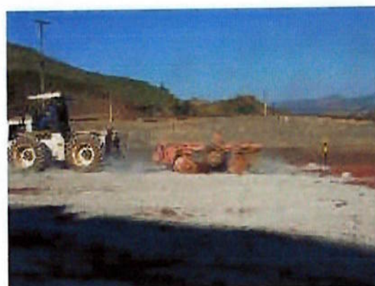
Homogeneização entre o solo e o cimento
