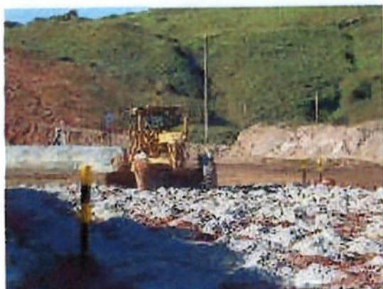
Homogeneização entre o solo e o cimento
