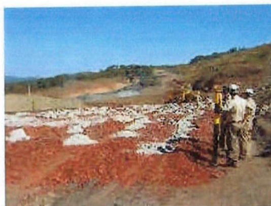
Espalhamento do cimento sobre a camada de solo
