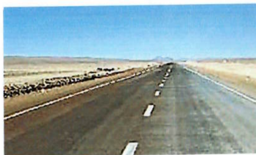
Figura 5.2 – Estrada estabilizada com cloreto de magnésio (bischofita). Local : acesso à Minera El Tesoro – Chile.
