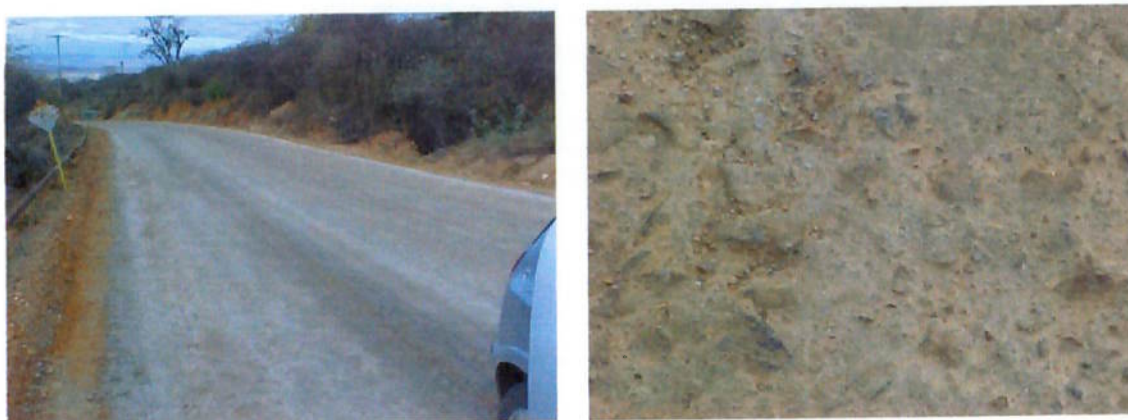
Figura 5.4 – Imagens de uma estrada estabilizada com cimento Sorel. Local : Mina Magnesita – Brumado - BA
