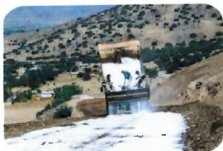
Figura 5.3 – Estabilização de estrada com o emprego de cloreto de sódio (sal comum). Local : Chile
