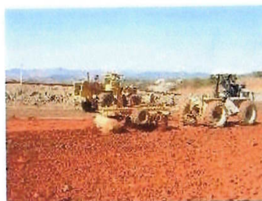
Formação de sulcos sobre o solo espalhado
