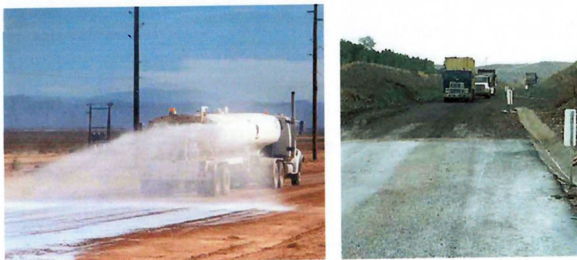
Figura 5.5 – Etapas do processo de estabilização de uma estrada com o emprego de copolímero acrílico. Local : Estados Unidos.
