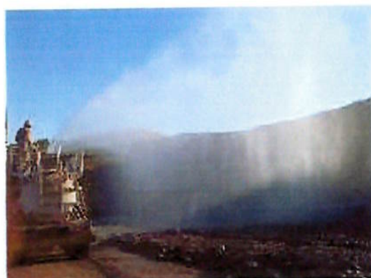
Umidificação para se alcançar a umidade ótima de compactação
