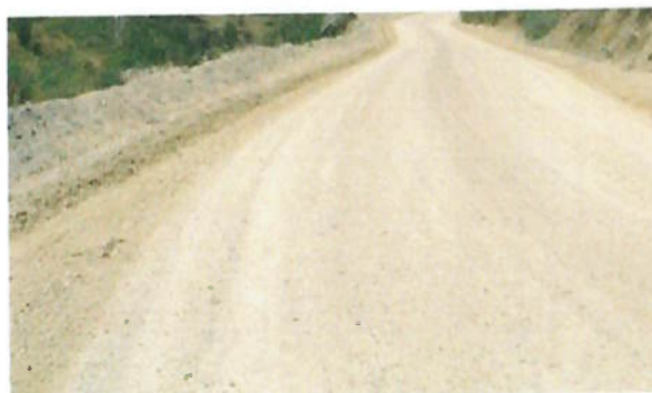
Figura 5.3 – Estabilização de estrada com o emprego de cloreto de sódio (sal comum). Local : Chile
