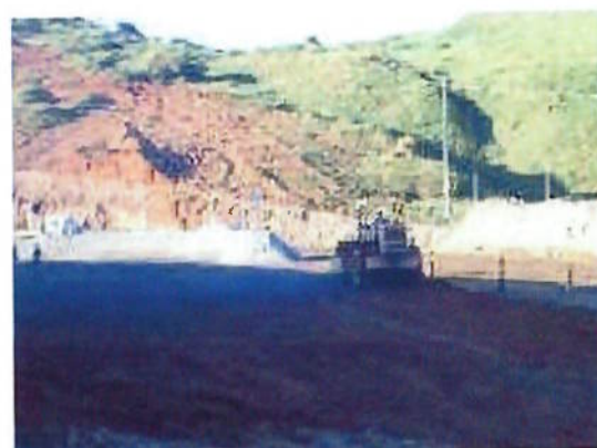
Compactação final da camada de solo-cimento
